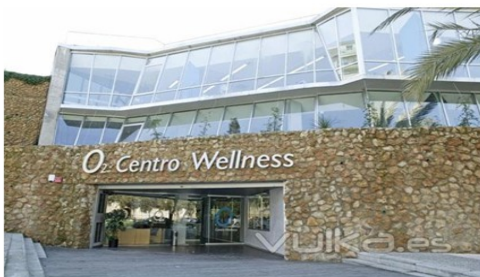
Оздоровительный центр O2, Уэльва, Испания
